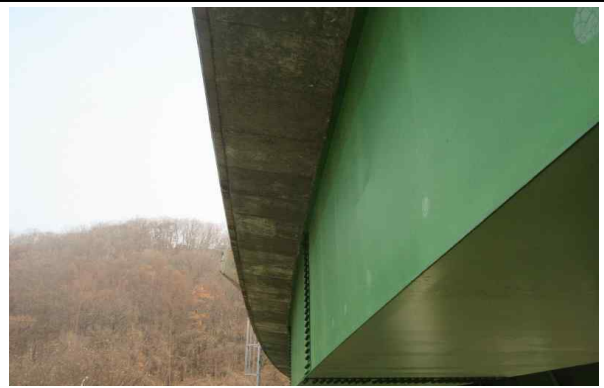
거더 외부 전경
