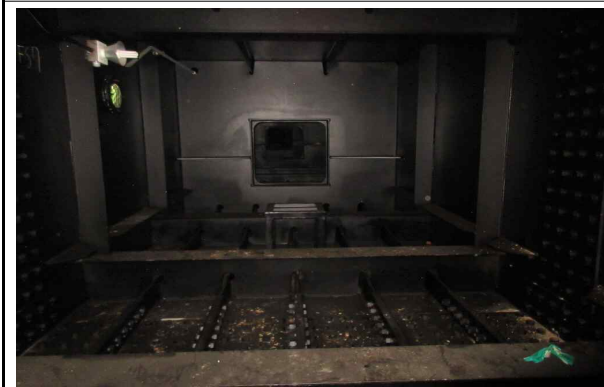
거더 내부 전경
