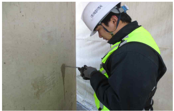
탄산화 깊이 측정
