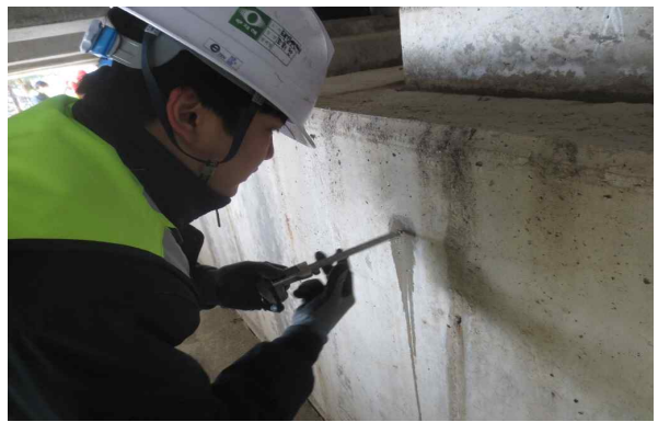
탄산화 깊이 측정
