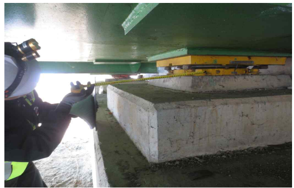
교량받침장치 연단거리 측정
