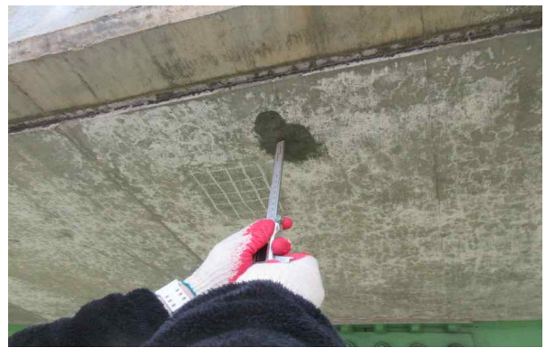
탄산화 깊이 측정
