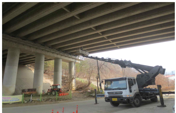
교량점검차를 이용한 외관조사
