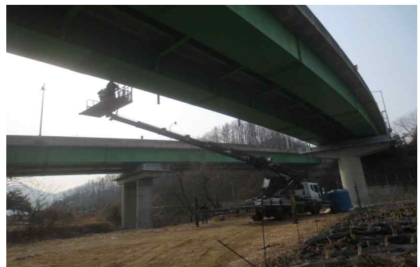
교량점검차를 이용한 외관조사
