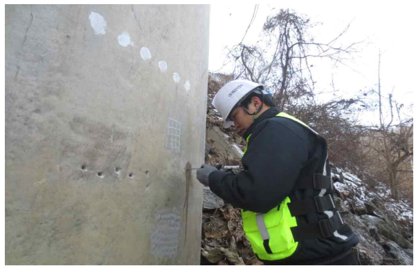
탄산화 깊이 측정
