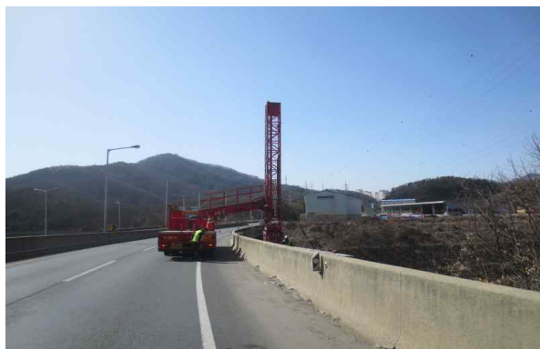
교량점검차를 이용한 외관조사
