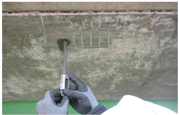
탄산화 깊이 측정
