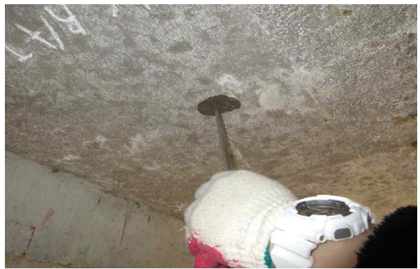
탄산화 깊이 측정
