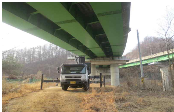
교량점검차를 이용한 외관조사
