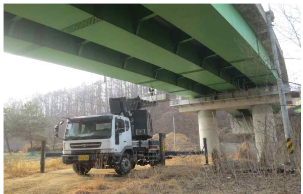
교량점검차를 이용한 외관조사
