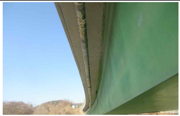
거더 외부 전경
