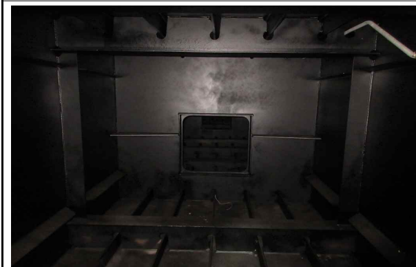
거더 내부 전경
