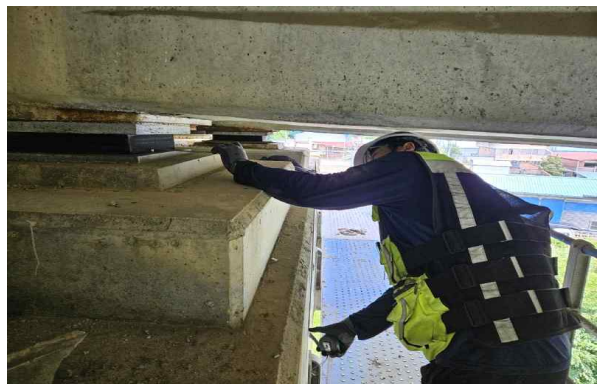
교량받침장치 연단거리 측정
