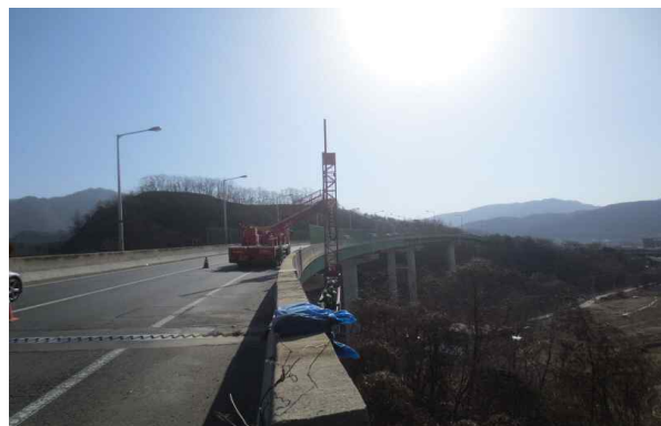
교량점검차를 이용한 외관조사
