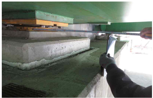
교량받침장치 연단거리 측정
