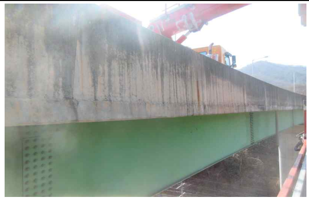
거더 외부 전경
