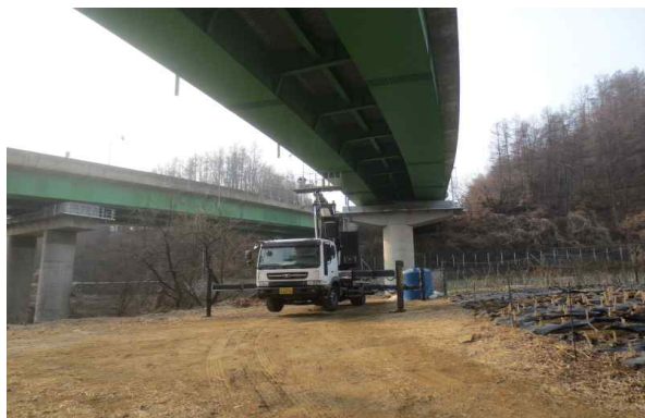
교량점검차를 이용한 외관조사
