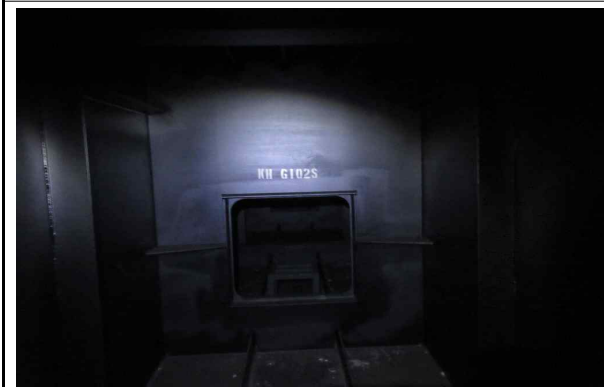
거더 내부 전경
