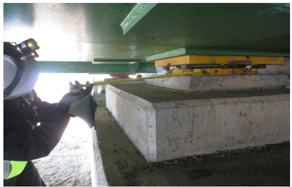
교량받침장치 연단거리 측정
