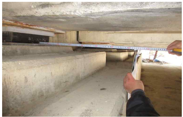
교량받침장치 연단거리 측정
